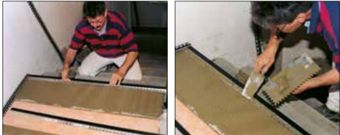
1. Выберите профиль в соответствии с толщиной плитки и разрежьте его до подходящей длины. Затем приложите профиль к ступеньке таким образом, чтобы верхняя кромка подходила по высоте. Потом нанесите клей для плитки на край ступени, а также заполните клеем для плитки полости на нижней стороне профиля.
