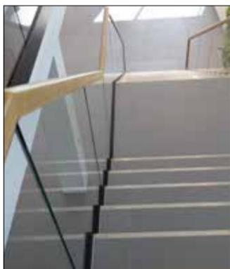
Благодаря своим противоскользящим свойствам и хорошей визуальной различимости Schlüter-TREP обеспечивает повышенную безопасность.
