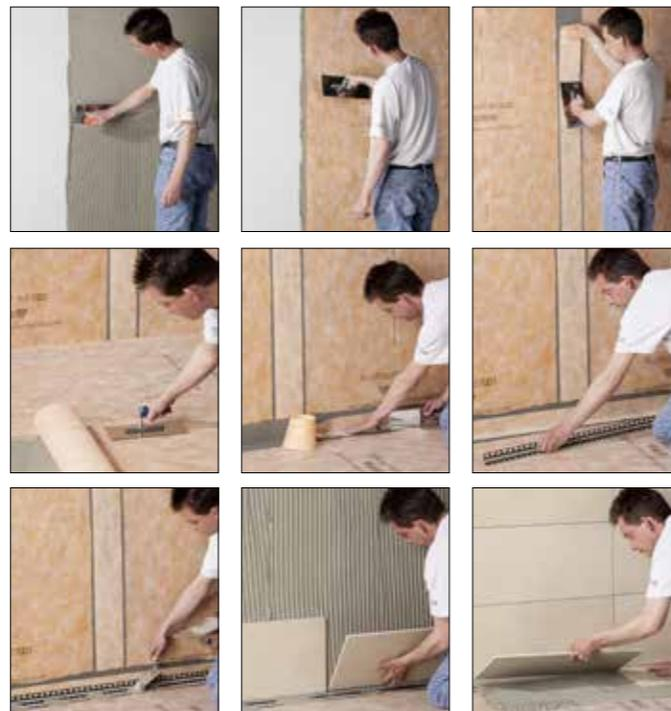
1. Изолируемая поверхность должна быть чистой, ровной и способной нести нагрузку. Нарежьте полотно с помощью ножниц или ножа для ковров до необходимых размеров. Для облегчения раскроя на одну из сторон полотна Schlüter-KERDI нанесена разметочная сетка.
