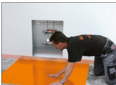
4 Verteilerbereich – Ausgleichsplatte Schlüter-BEKOTEC-EN FG (glatte Folienplatte) einpassen.
