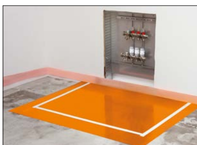
5 Verteilerbereich – beigefügte Doppelklebebänder aufbringen.
