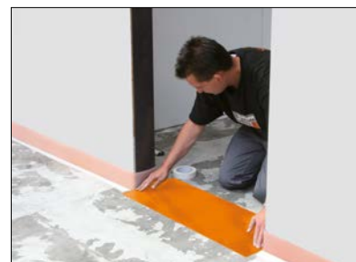
6 Türbereich – Ausgleichsplatte EN FG (glatte Folienplatte) einpassen.
