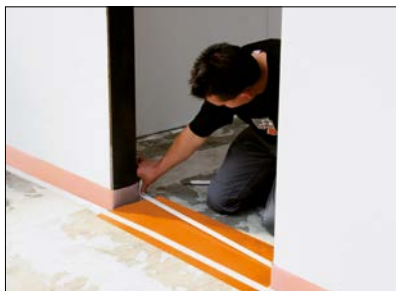
7 Türbereich – beigefügte Doppelklebebänder aufbringen.
