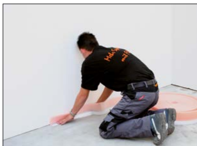
2 Einbau des Randstreifens BRS 808 KSF mit Klebestützfuß.
