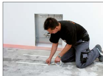
3 Verteilerbereich – beiliegendes Doppelklebeband auf dem Boden anbringen.
