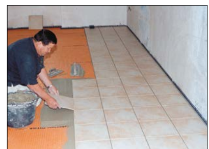
12 Verlegung des Fliesenbelags auf DITRA in Dünnbettmörtel.
