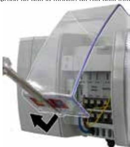
1. Abra la cubierta usando un destornillador plano.
